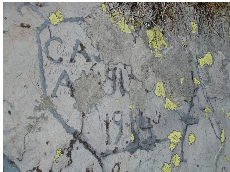
↑ [fig. 24] développement du lichen favorisé par l'eau stagnante dans les rainures.
