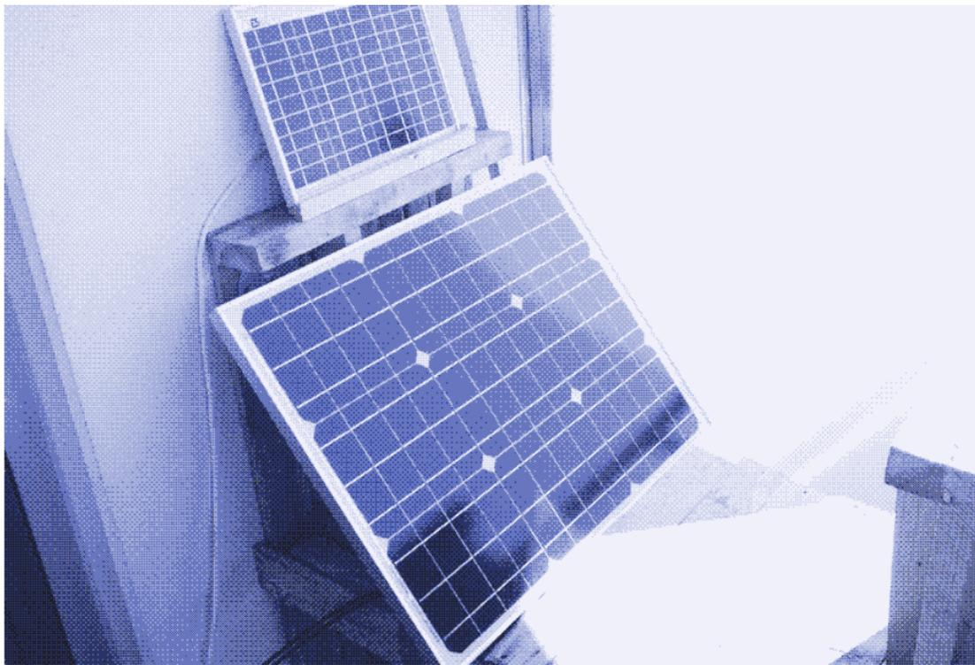
Image: Le panneau photo-voltaïque solaire de 50 W. Au-dessus, un panneau de 10 W qui alimente un système d'éclairage.
